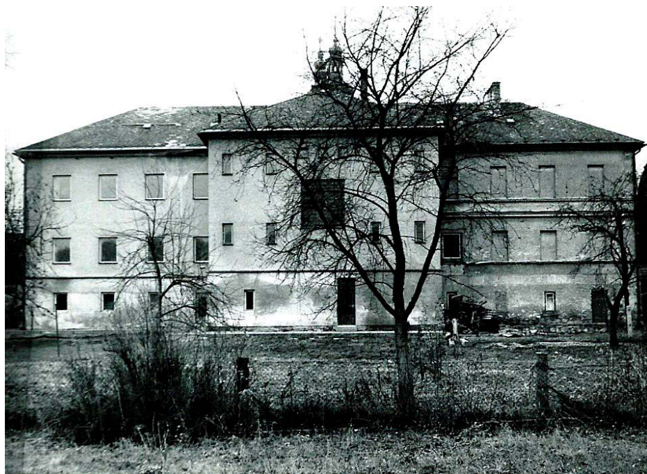
Základní škola před rekonstrukcí
