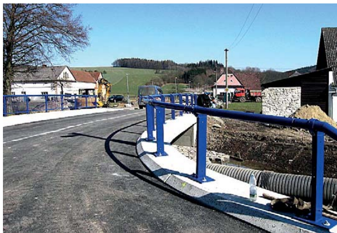
Modernizace silnice II/315 Tatenice – Hoštejn
