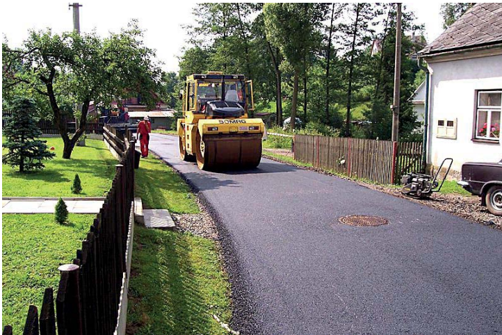
Oprava komunikace do Kátru
