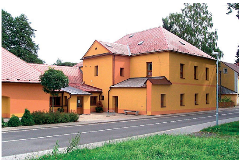
Mateřská škola po rekonstrukci
