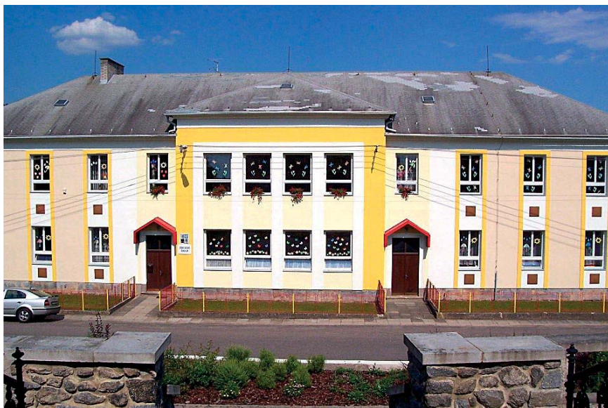
Základní škola po rekonstrukci – stará budova z roku 1896
