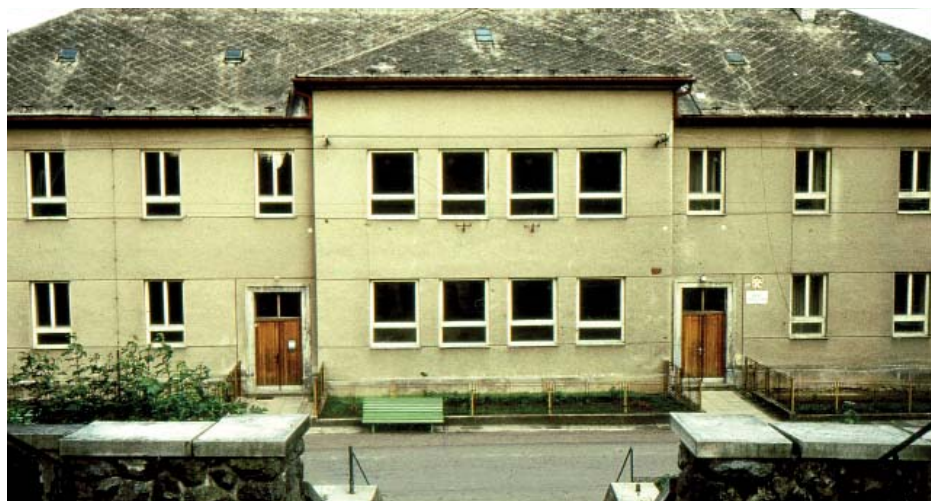
Základní škola před rekonstrukcí
