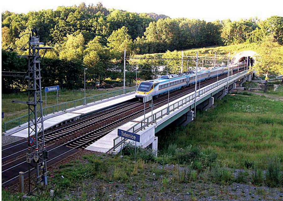
Nová vlaková zastávka umístěná na mostě mezi dvěma tunely – Tatenickým a Krasíkovským z roku 2004
