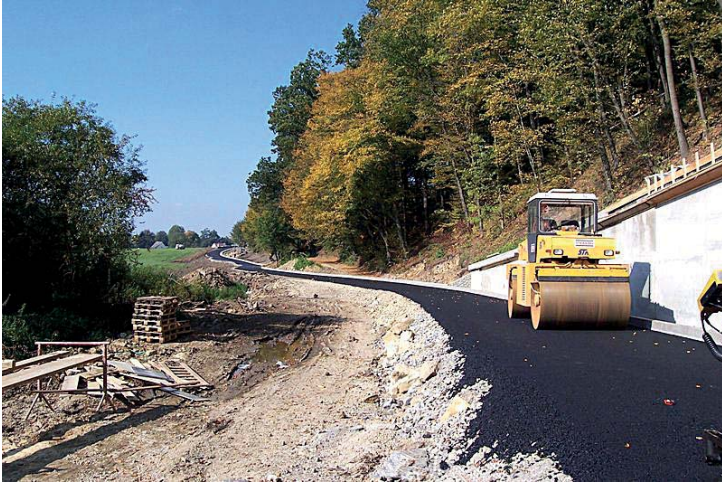
Stavba přístupové komunikace k nové vlakové zastávce
