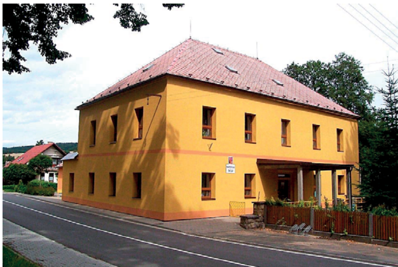
Mateřská škola po rekonstrukci
